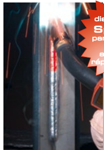
Soldadura vertical ascendente con SpeedUp
