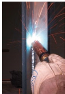
Soldadura vertical ascendente hasta ahora
